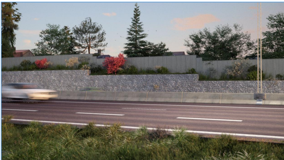
Figur 35. Illustration som visar hur bulleråtgärderna med skärm och stödmur utmed villaområdet Backen/Ljungarum dämpas via planteringar.
