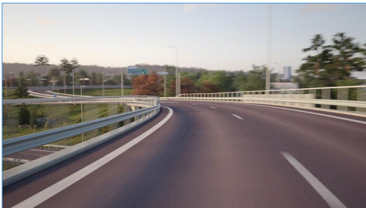
Figur 34. Vy från bron norr ut mot Jönköping.
