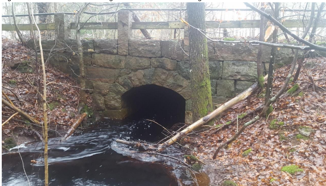
Figur 25. Stenvalvsbro på östra sidan
