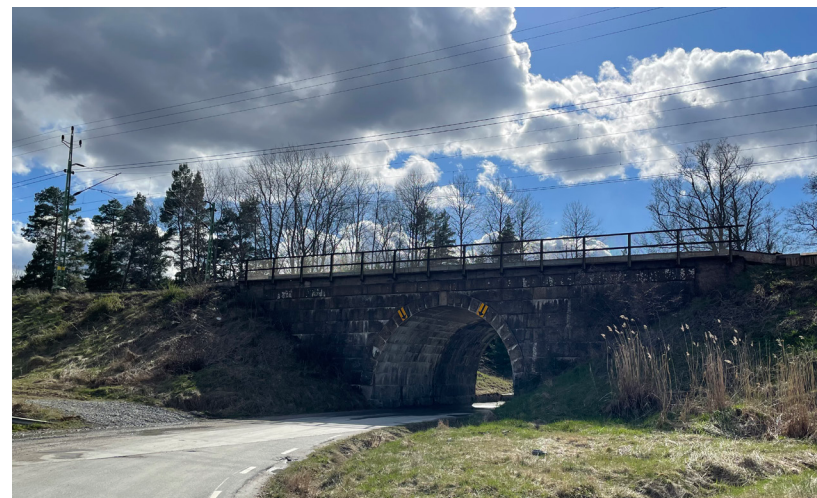
Figur 66. Stenvalvsbro från 1866 för passage och omledning av vattendrag under järnvägen. Vattendraget är i dag kulverterat.
