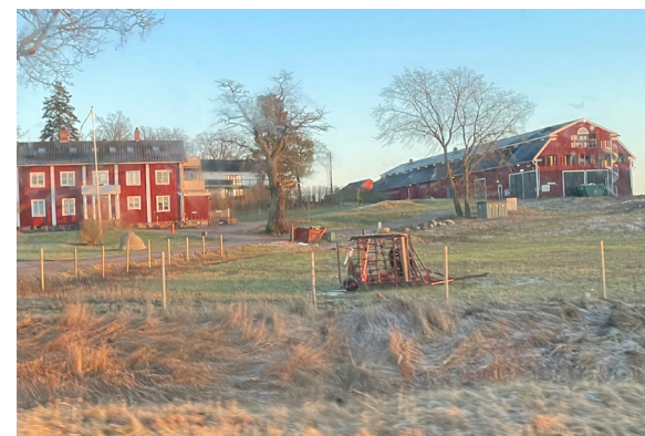
Figur 39. Söderby gårds huvudbyggnad, uppförd under 1700-tal, och ekonomibyggnad.
