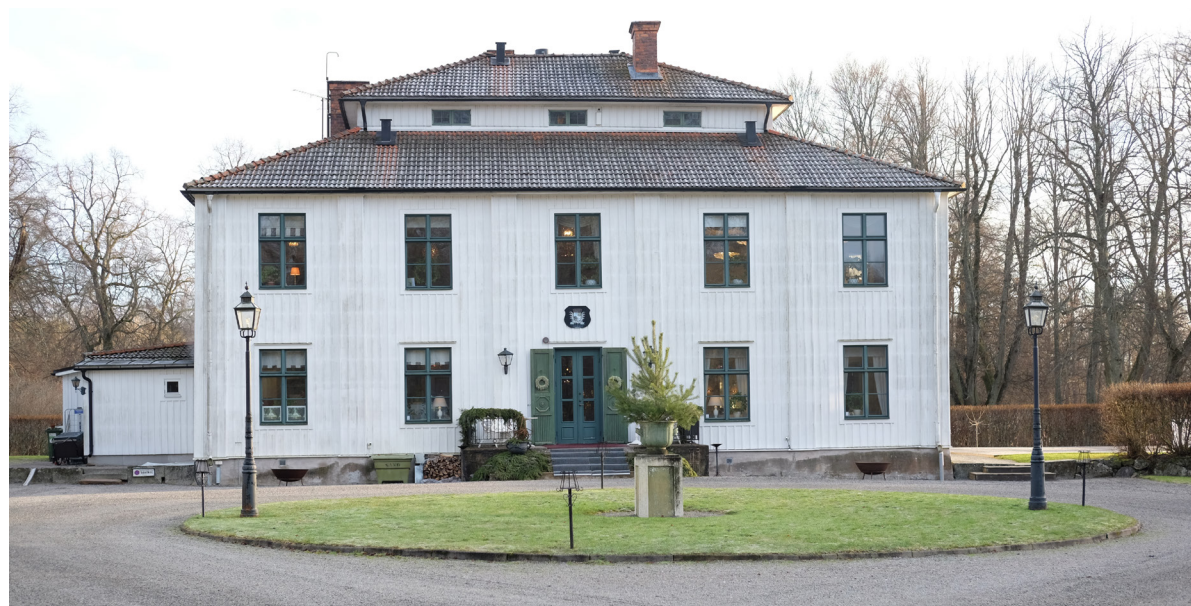
Figur 51. Huvudbyggnaden vid Nor.
