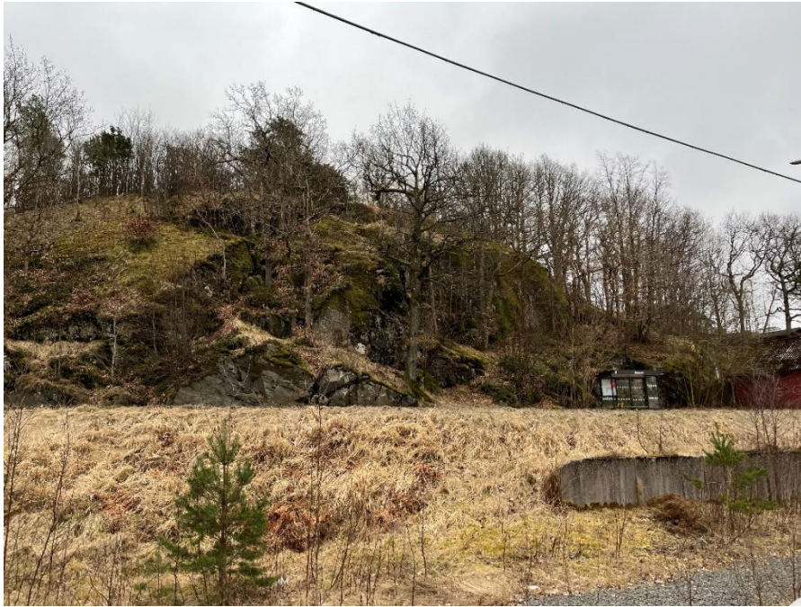
Figur 11 Vy från pendlarparkeringen upp mot bergskärningen och stödmur i betong.
