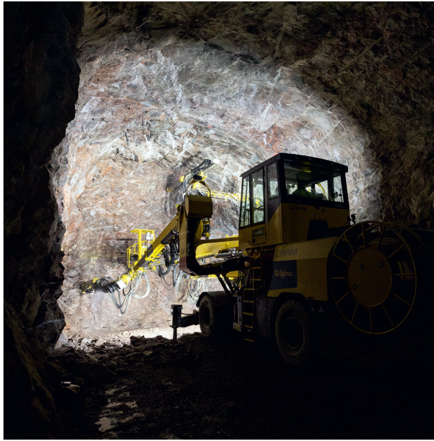
Bild inifrån servicetunnel Linné. I mitten på maj har vi nått 618 meter in i berget. Du som bor eller arbetar ovanför eller längs med servicetunneln kan märka av våra tunnelarbeten i cirka 1-2 månader.
