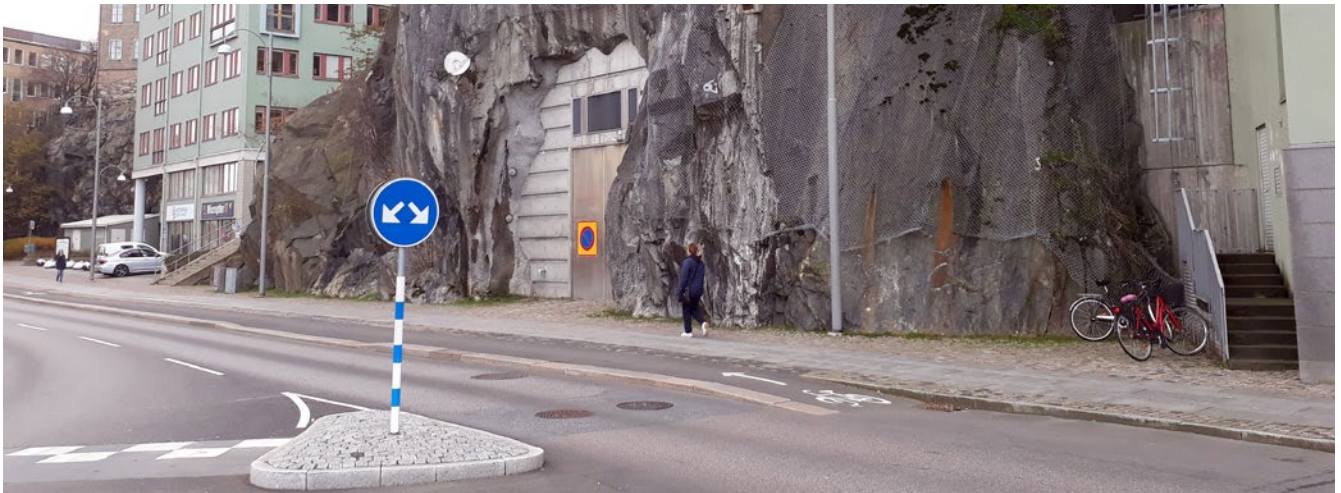
Bergsmassorna från bygget av Västlänkens spårtunnel kommer att gå via Götatunnelns befintliga servicetunnel. Foto: Trafikverket.
