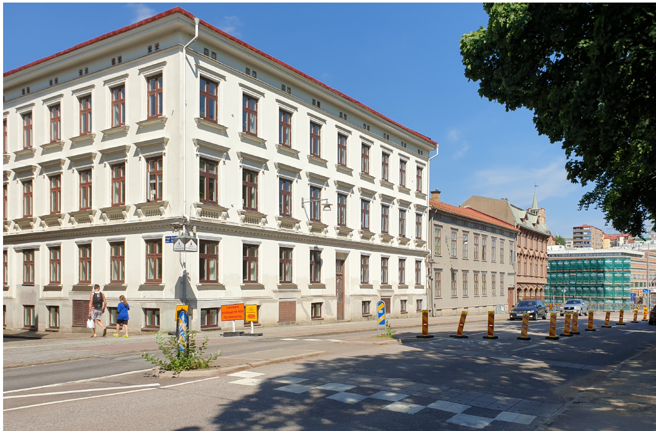
Sprängkullsgatan ned mot Allén. Sträckan stängs av i höjd med Haga Östergata från och med 1 oktober.
