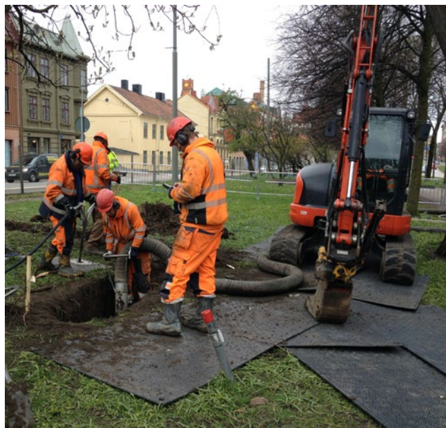
Runt de träd som ska förberedas gräver vi ett dike på fyra sidor av trädet, en till en och en halv meter djupt, beroende på rotsystemet. Jorden tas bort med hjälp av bland annat vakuumsugning för en skonsam behandling av de rötter som friläggs. Foto: Västlänken
