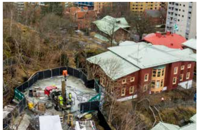
Senhösten 2020 började vi täta berget genom injektering. Injektering innebär att vi fyller de sprickor som finns i berget med en vatten- och cementblandning. Foto: Kasper Dudzik
