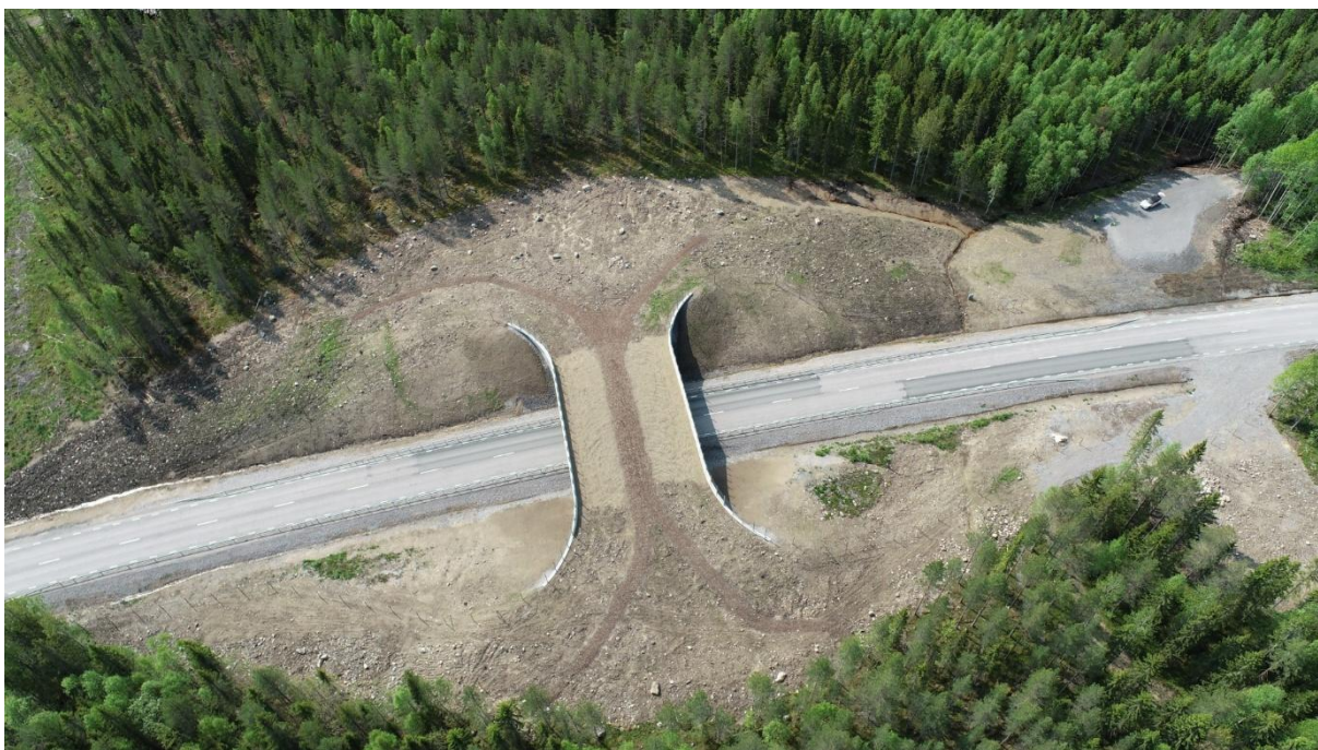
Figur 17. Exempel på faunabro. Bilden visar en faunabro över E4 Bredviksheden under byggtiden.
