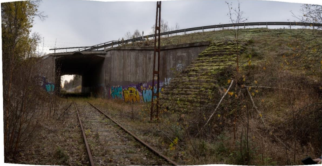
Figur 4.5 - Bro 21-211-1 är en vägbro över järnvägen Dellenbanan. Foto mot sydost.
