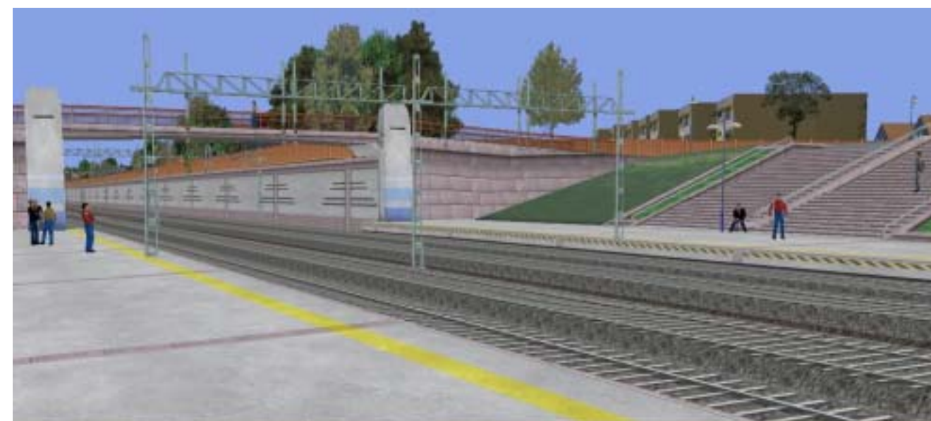
Figur 62. Idéförslag till utformning av station med järnvägen försänkt 5,5 meter. (bild ur VR-film)
