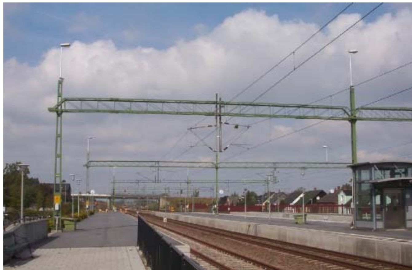
Figur 24. Kontaktledningsstolparna målas gröna
