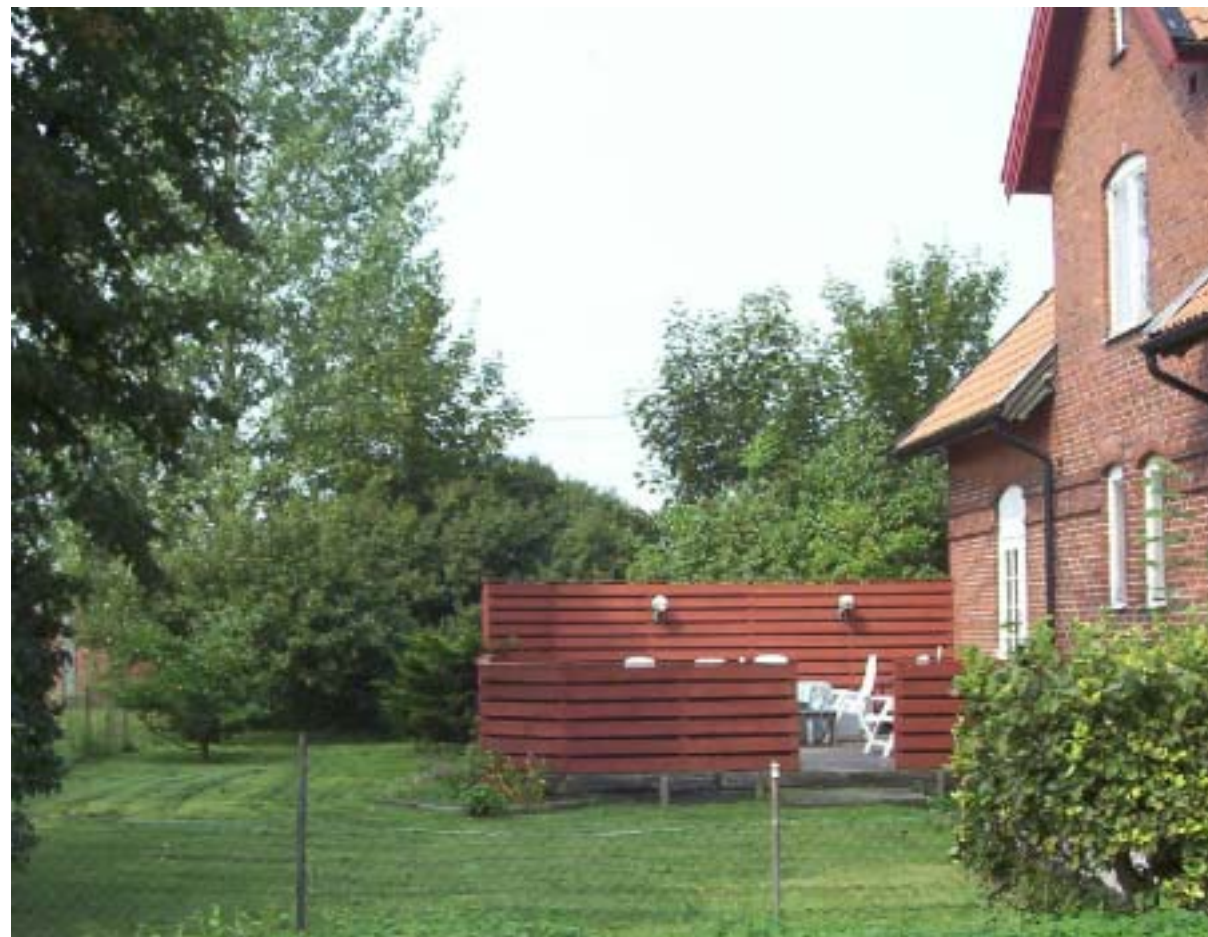
Figur 28. Exempel på bullerskydd vid uteplats i Hjärup
