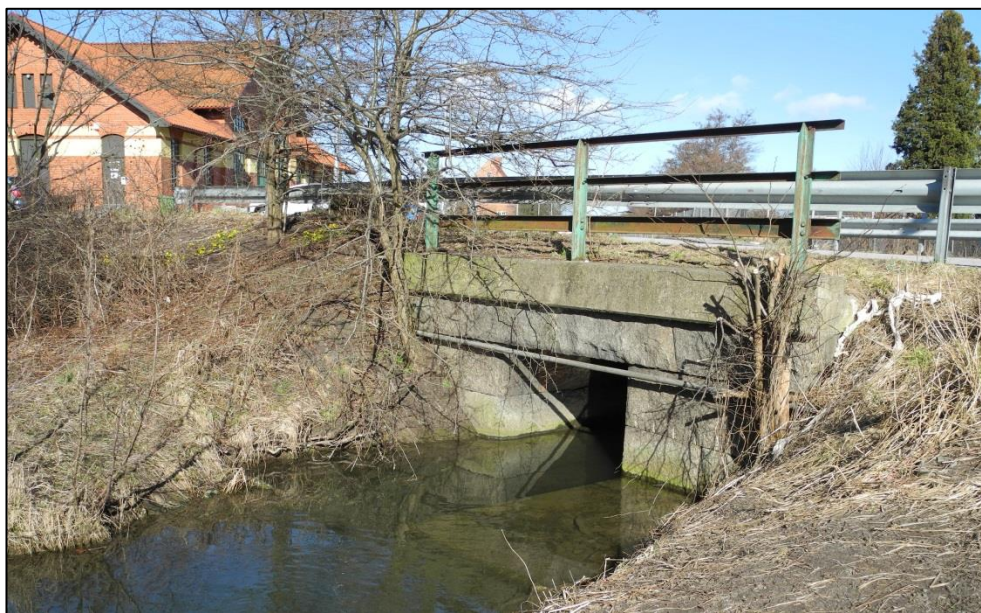
Figur 2.2 Bro vid Stationsvägen i Åkarp. Bredd 1,65 m, höjd 1,5 m.
