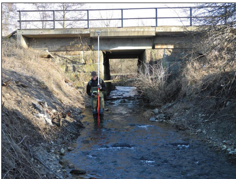
Figur 2.5 Bro vid stambanan i Arlöv. Bredd cirka 2,45 m, höjd cirka 2,7 m.
