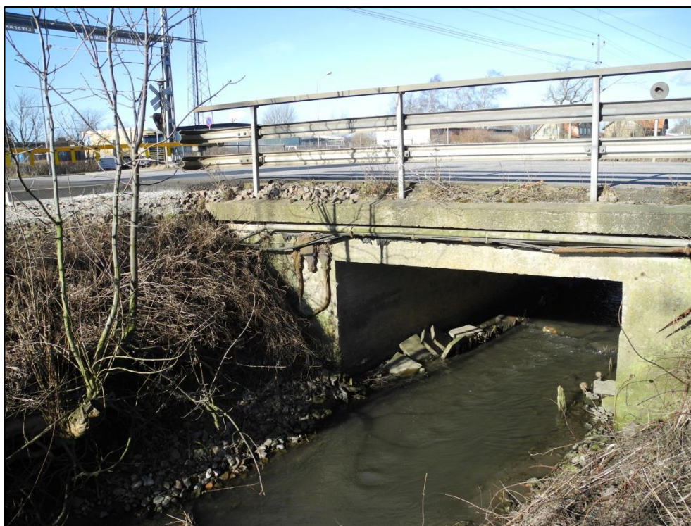
Figur 2.3 Bro vid Alnarsvägen i Åkarp. Bredd varierar mellan 1,7-2,8 m, höjd cirka 1,7 m.
