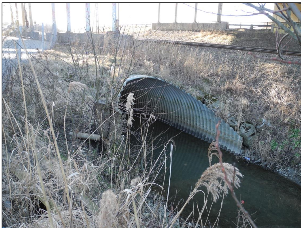
Figur 2.4 Elipsformad trumma av korrugerad plåt vid E6/E20, bredd cirka 3 m. Mellan Åkarp och Arlöv.
