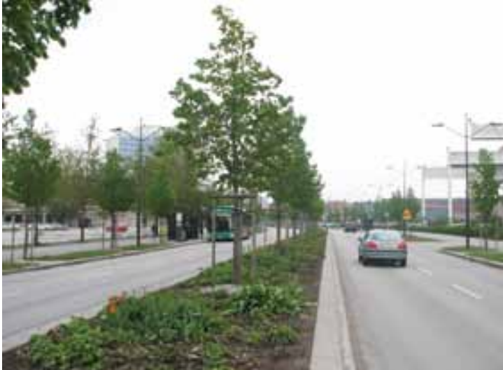
Stora Varvsgatan i Malmö är en länk i huvudnätet för samtliga trafikslag. Framkomligheten är god men det intima gaturummet har försvunnit.
