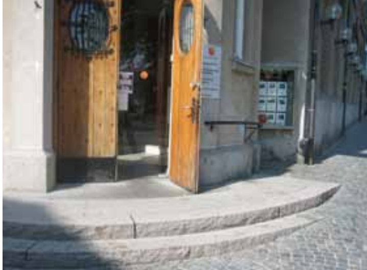
Exempel på hur entré ovanför markytan kan utformas. Kontrastmarkering saknas dock på trappstegen och smågatstenen är ojämn.
