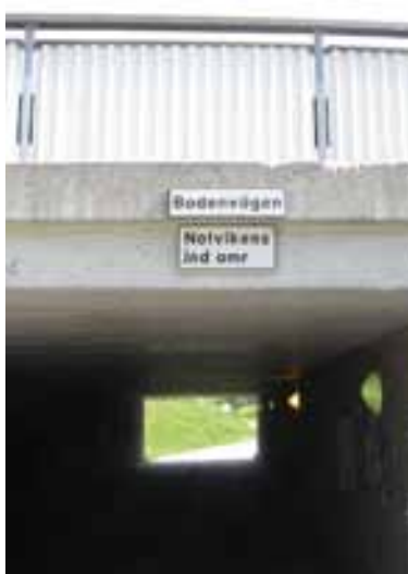
Skyltarna vid gc-tunneln i Luleå talar om för cyklisterna vilken väg de passerar samt vilket område man nått.
