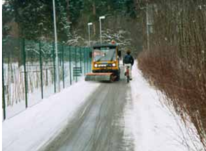
Borstning och spridning av saltlösning på en gång- och cykelväg i Linköping.
