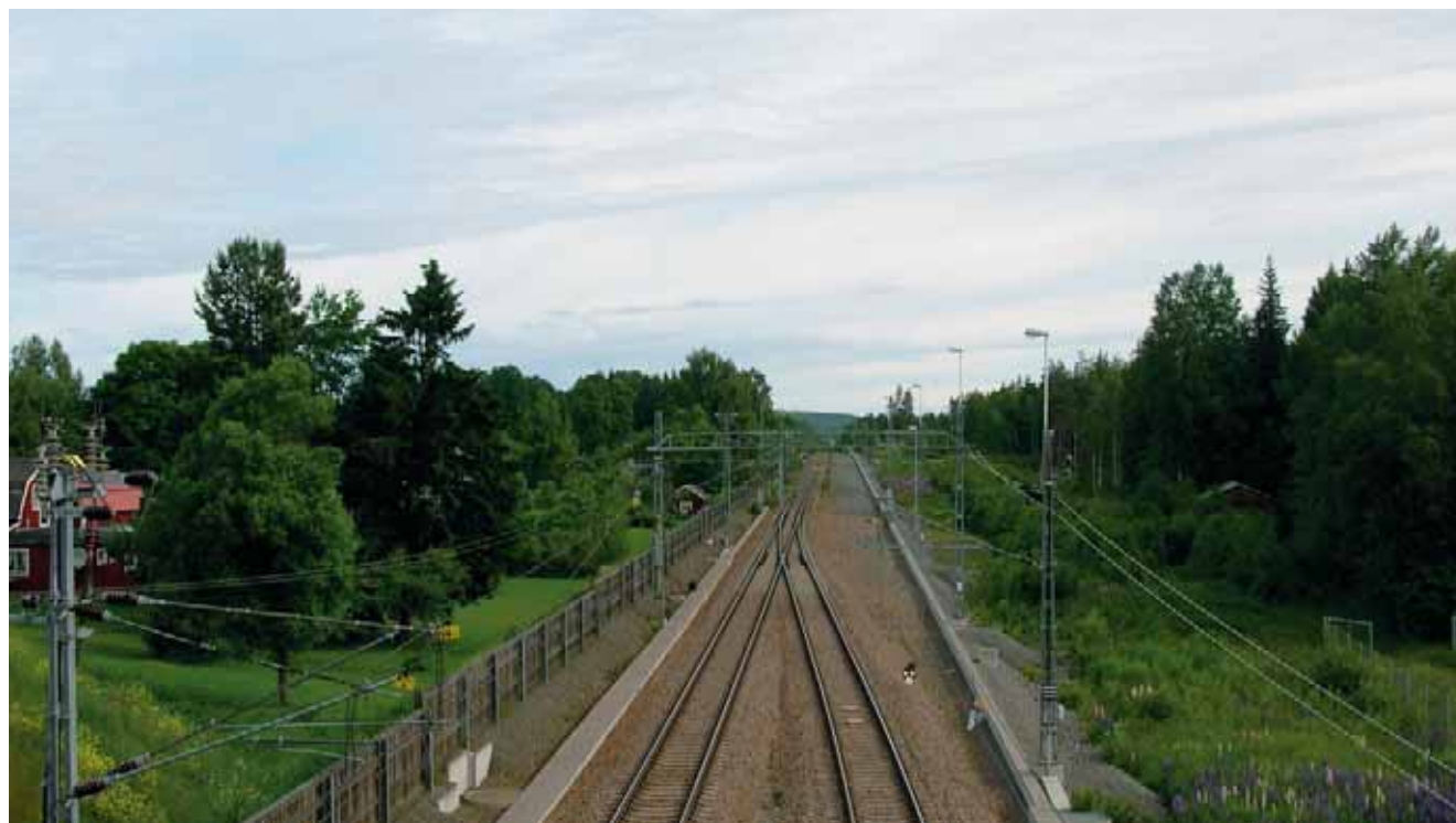
Bild tagen från Degerön och norrut. Endast ett komplett dubbelspår undanröjer helt risken för trafikstörningar på grund av för högt kapacitetsutnyttjande. Idag övergår dubbelspåret till enkelspår norr om Degerön.
