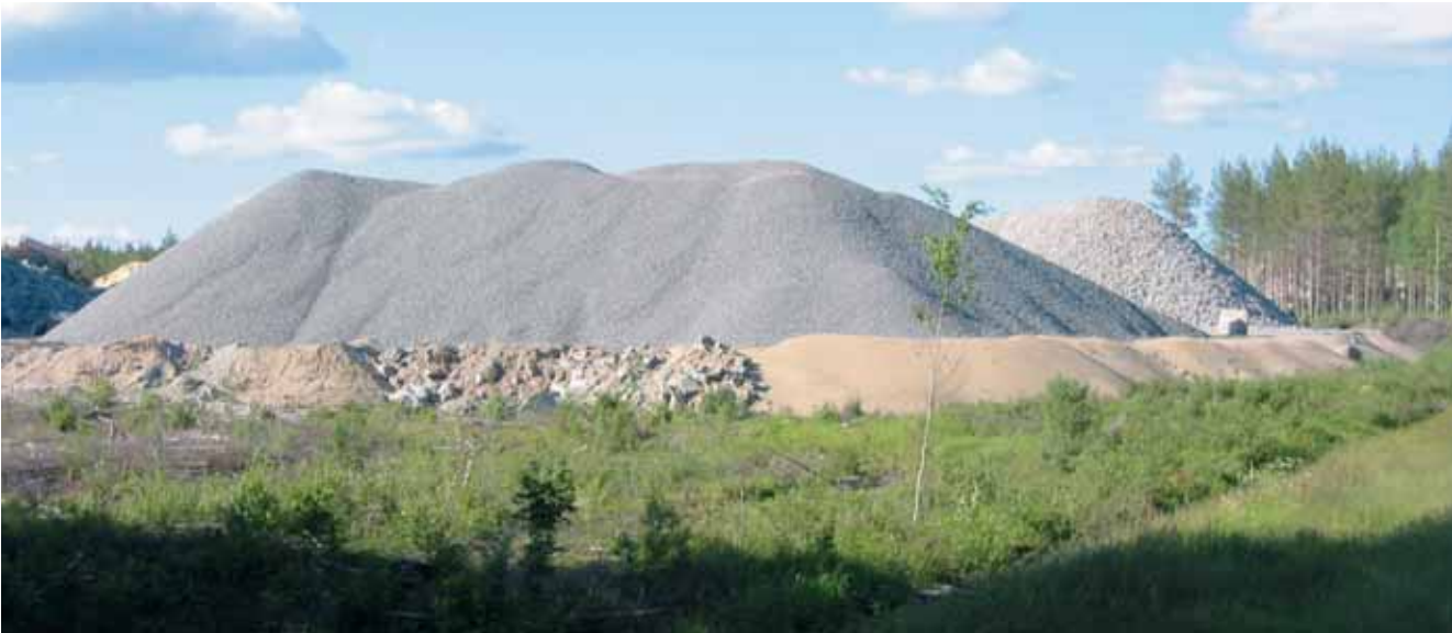
Stora mängder berg- och jordmassor krävs för att bygga järnväg..
