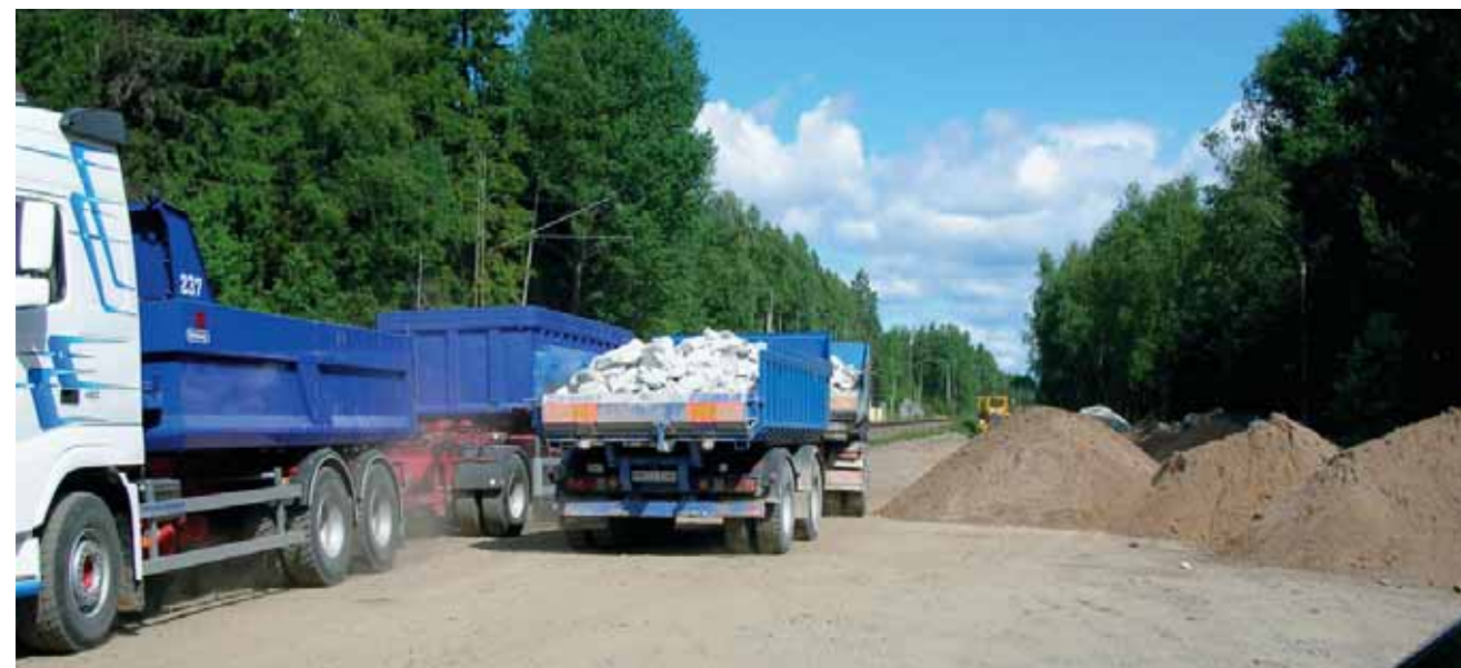
Omfattande transporter och damning kommer att uppstå vid byggande av den nya järnvägen.
