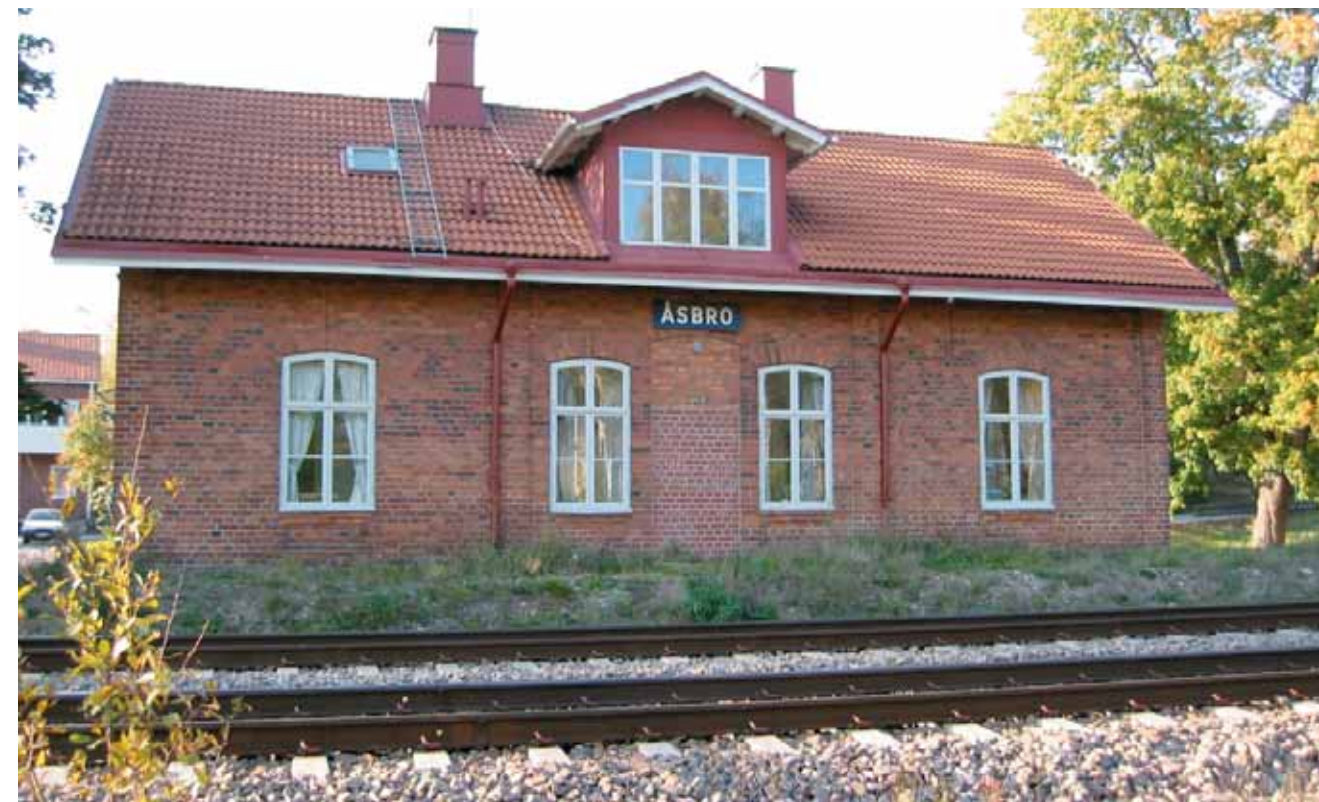
Kulturmiljön Åsbro. Stationshuset av tegel uppfördes i samband med att järnvägen genom Åsbro invigdes år 1873 och är frånsett Hallsberg den enda kvarvarande stationsbyggnaden längs den aktuella sträckan. Foto: Olof Pettersson.
