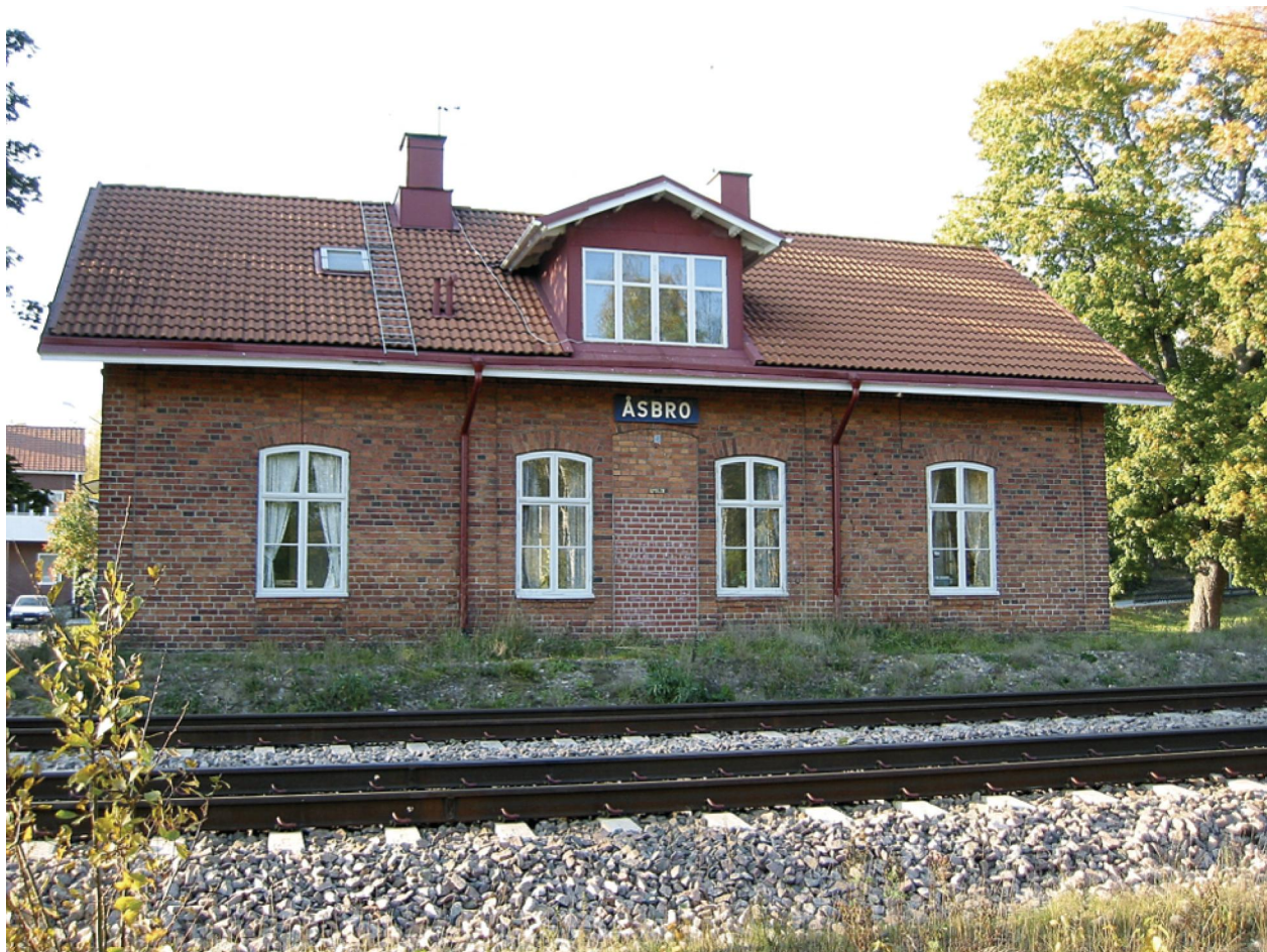
Kulturmiljön Åsbro. Stationshuset uppfördes i samband med att järnvägen genom Åsbro invigdes år 1873 och är, frånsett Hallsberg, den enda kvarvarande stationsbyggnaden längs den aktuella sträckan. Foto: Olof Pettersson.
