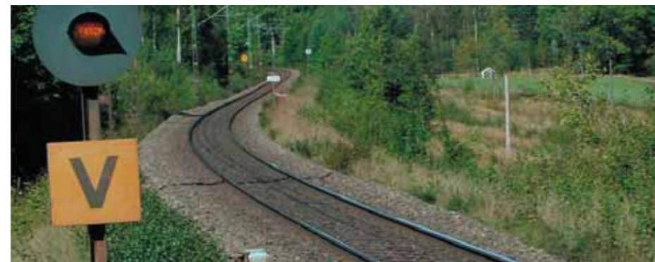
Figur 3.9 Befintligt spår vid Dunsjö med liten kurvradie.
