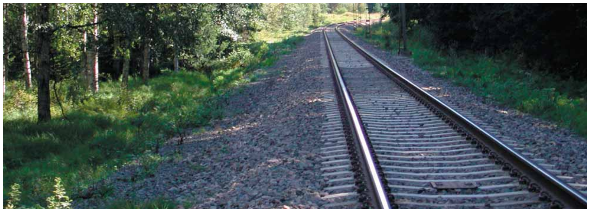
Figur 3.7 Befintligt enkelspår begränsar kapaciteten på sträckan.
