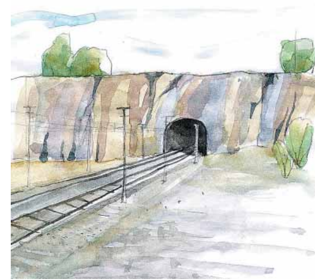
Figur 3.18 Tunnelpåslag utan förskärning.
