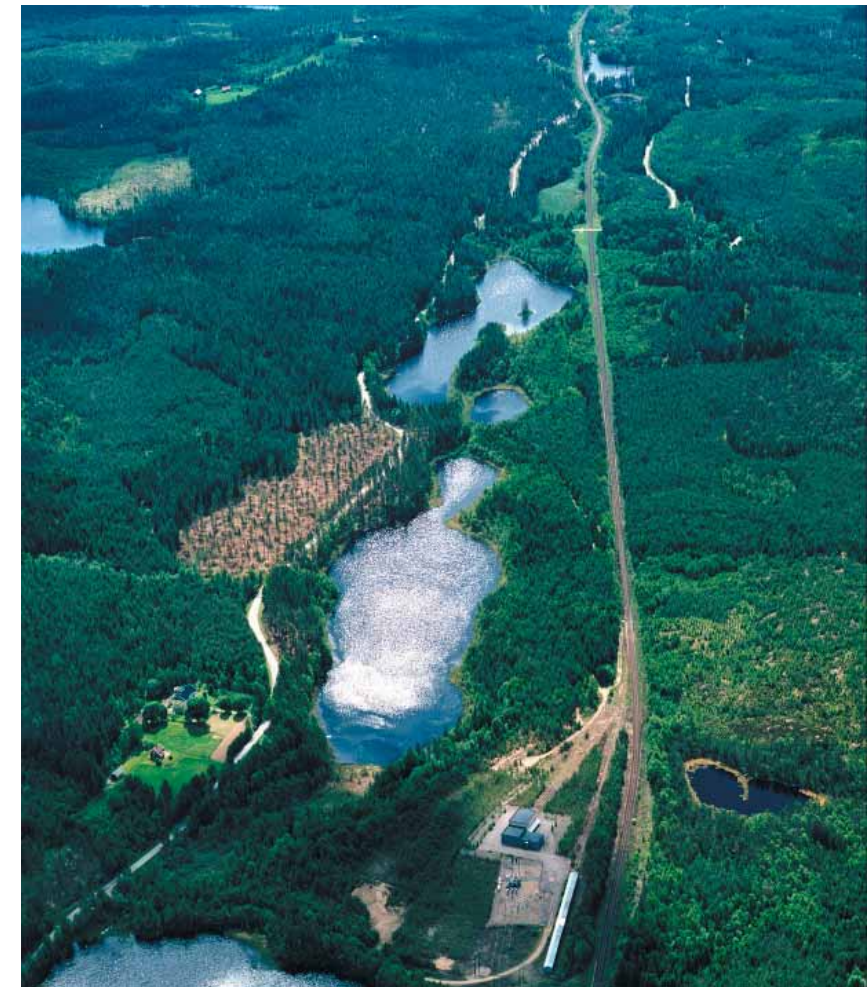
Figur 4.8 Sprickdalen Länsgränsen – Godegård med isälvsformationer av stort värde. Utbyggnad till dubbelspår kombinerat med viss kurvrätning innebär skärningar och påverkan beroende på omläggning av enskilda vägar på avsnitt sträckan Dammen-Unnagölen (bildens bortre del).
