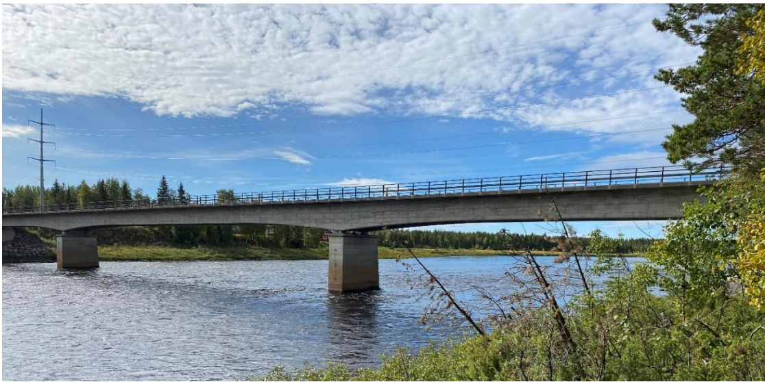
Figur 4. Foto befintlig bro. Vy åt väster.
