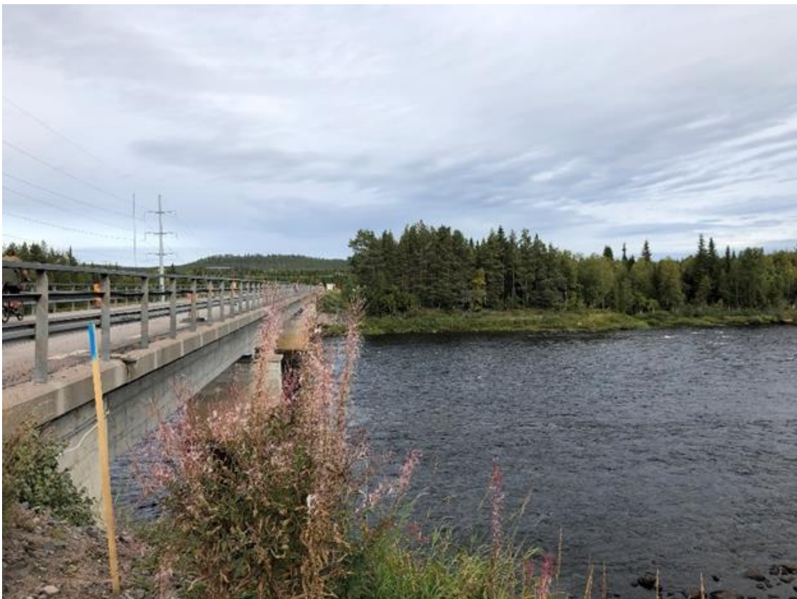
Figur 13. Strandområde på östra sidan om befintlig bro sedd från södra sidan av Torneälven.
