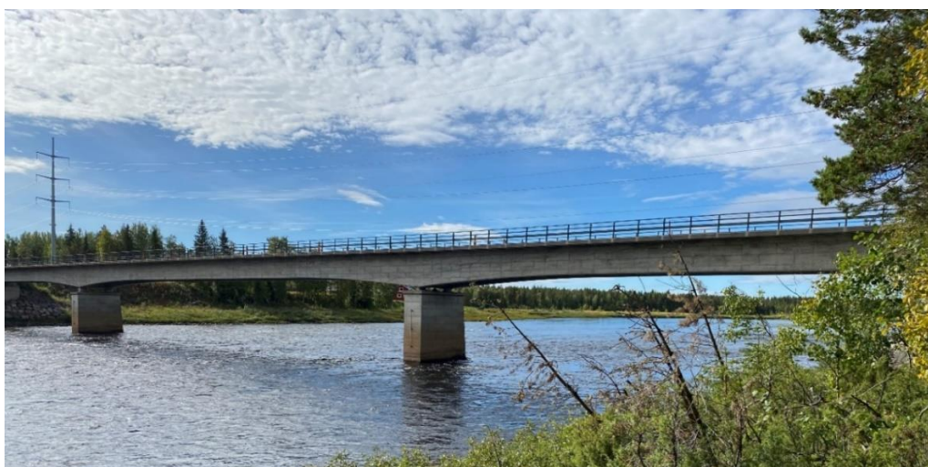
Figur 3.2-2. Foto befintlig bro. Vy åt väster.
