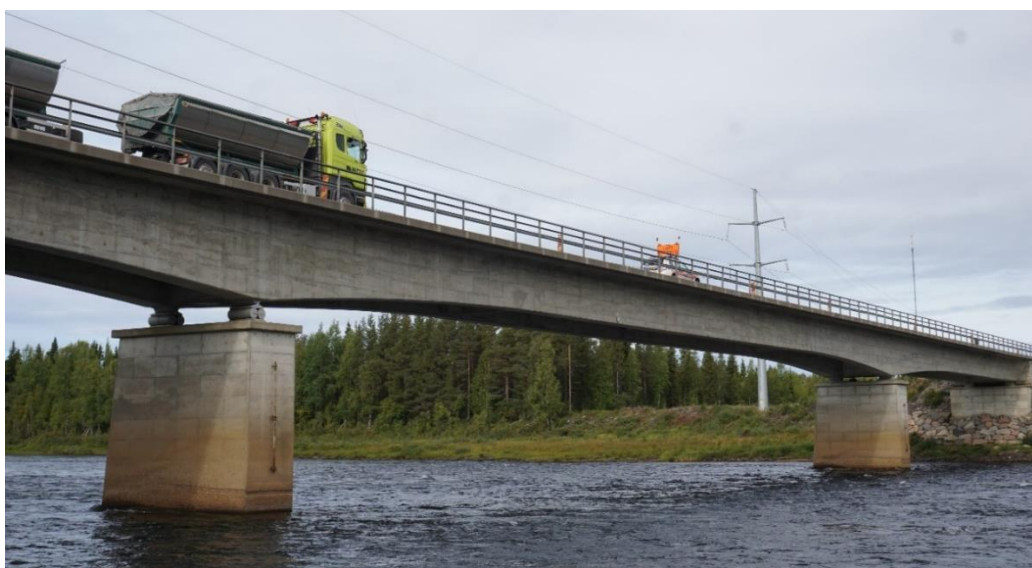
Figur 3.2-3. Foto befintlig bro. Vy åt nordväst.
