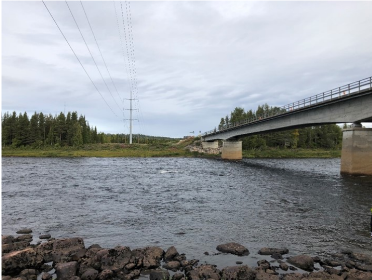
Figur 15 Västra sidan av bron sedd från södra sidan av Torne älv.
