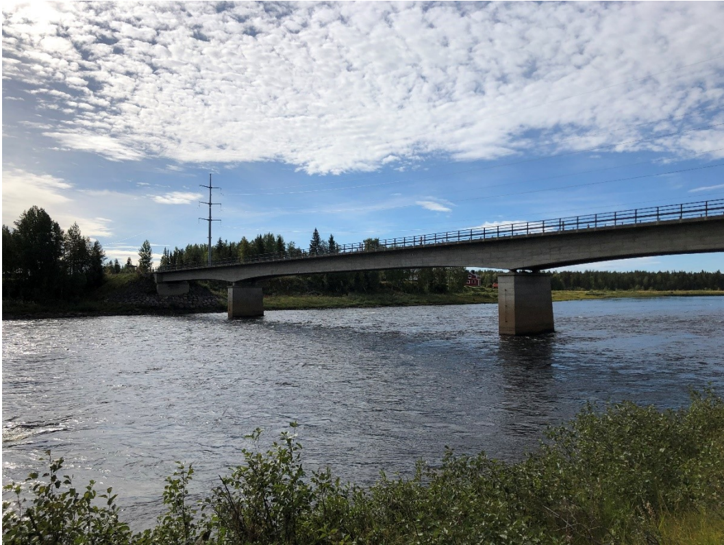
Figur 24. Befintlig bro sett från öster.
