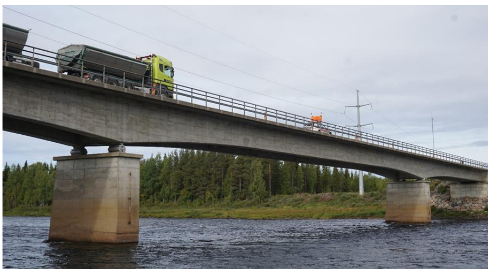
Figur 4 Befintlig bro vy åt nordväst.
