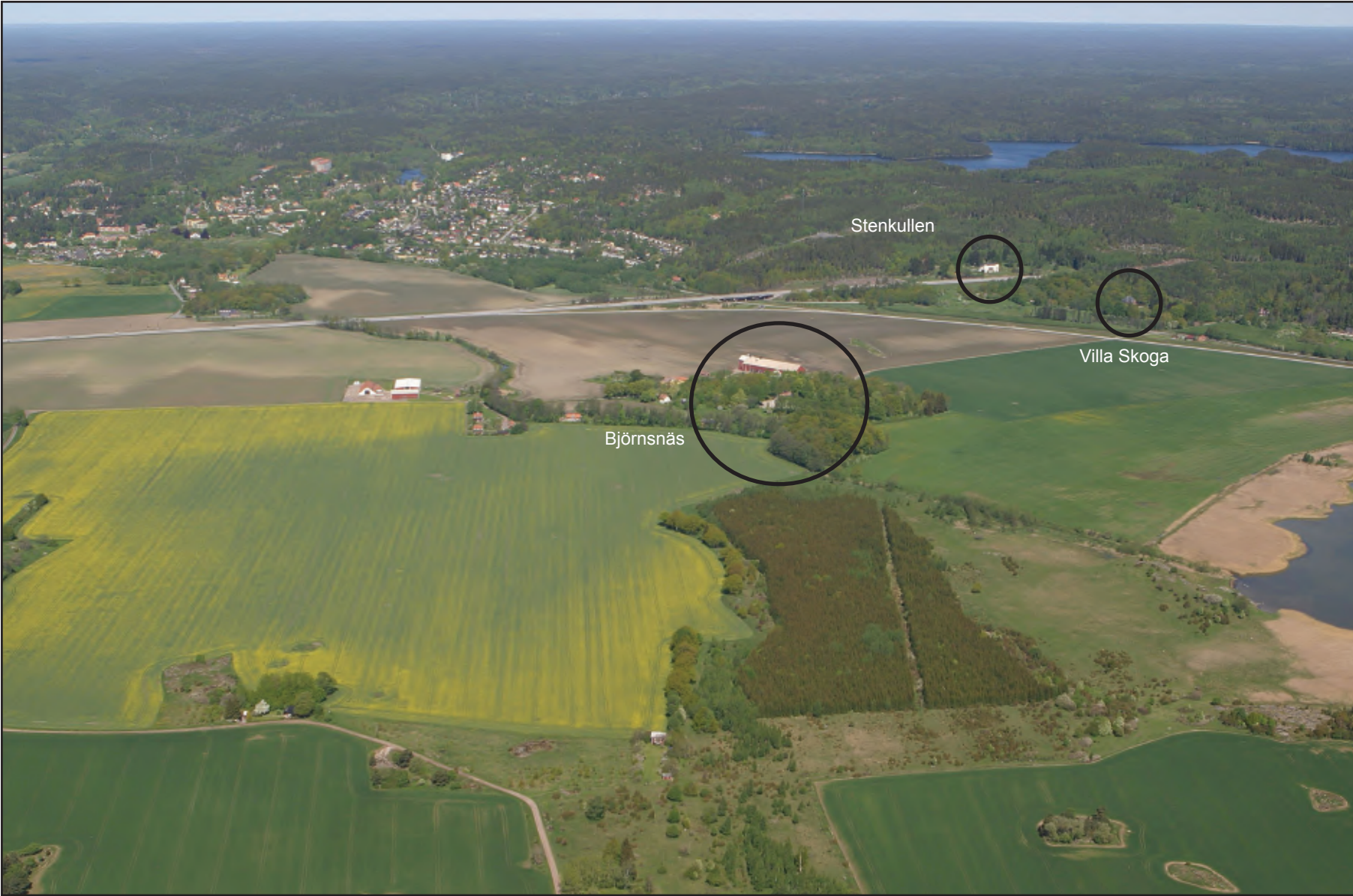
Figur 10. Flygbild över Björnsnäs och kolmårdsbranten med Björnsnäs, Villa Skoga och Stenkullen markerade. Foto Trafikverket.
