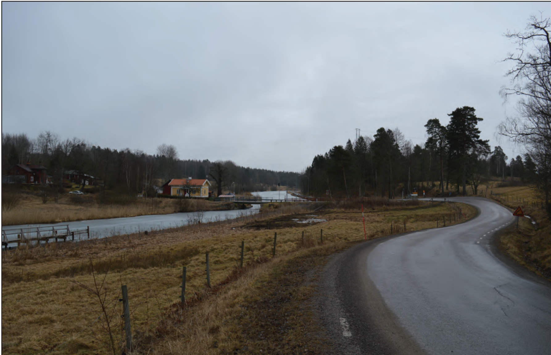
Figur 30. Göta kanal skär igenom landskapet flankerat av ett rikt kulturlandskap med färdvägar, betesmark och byggnader. Längs kanalen finns slussar och slussvaktarboställen. På bilden syns Björnavad sluss med slussvaktarboställe.
