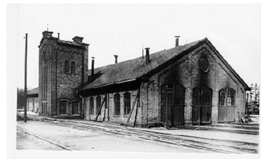
Fig. 49 De gamla lokstallarna som låg väster om stationen och banhallen ersattes 1913 med de nya halvcirkelformat lokstall invid Johannisborgs slottssruin. Fotograf okänd. Källa: Norrköpings stadsarkiv
