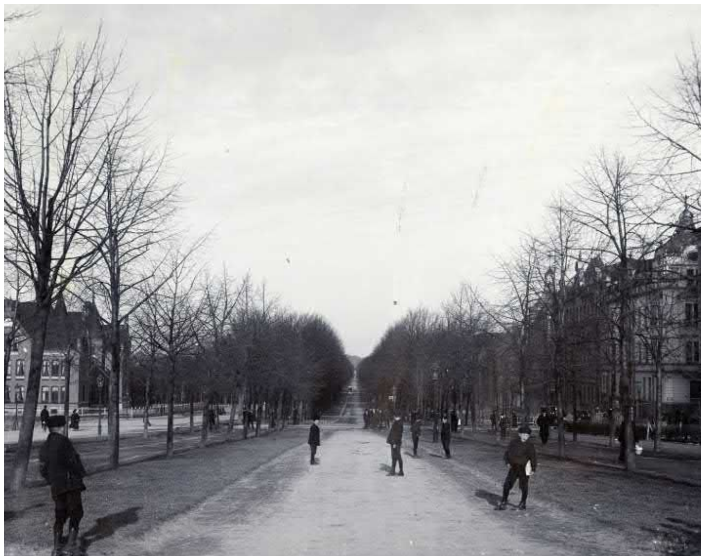
Fig. 14 Vy mot öster längs Norra Promenaden. Promenaden är en del av det allébälte som i princip löper kring hela centrala Norrköping och började anläggas under 1850-talet efter privat initiativ från snusfabrikör Erik Swartz. Planförslaget sprang ur det kontinental stadsplaneidealet med trädkantade esplanader med syftet att föra in ljus och luft i de annars täta storstäderna. I Norrköping förlades dock grönstrukturen som gränsalléer mellan stad och landsbygd, och inte mitt i staden som brukligt var. Källa: Norrköpings stadsarkiv.
