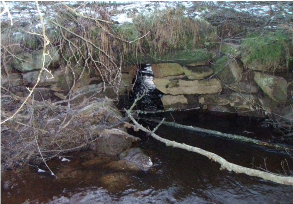
Bild 16. Delsträcka 2. De få inslagen av grövre bottenstrukt utgörs av nedfallna block från broposter.
