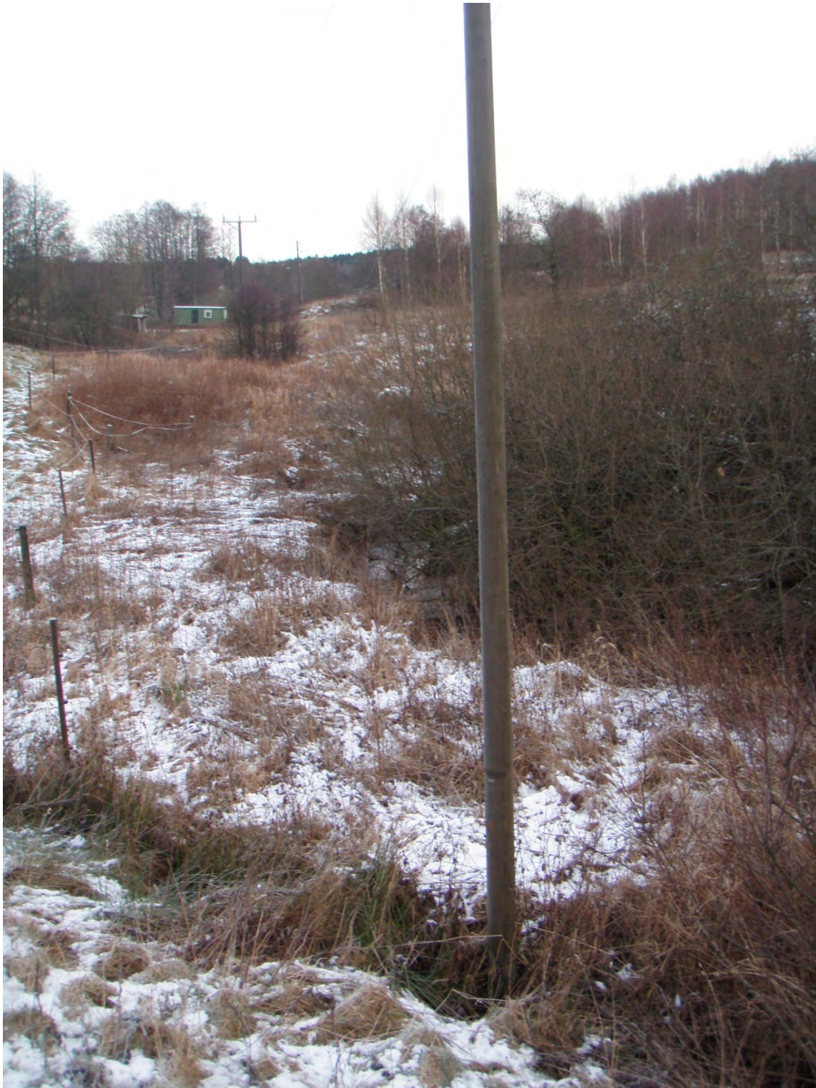
Bild 10. Delsträcka 6. I dalgången finns spår av äldre skålskred. Viss beskuggning i form av salixsnår finns kvar.
