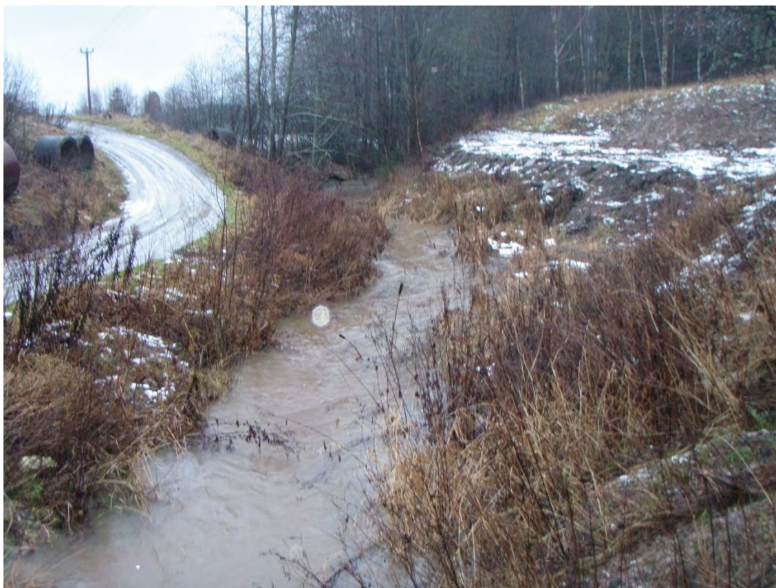
Bild 24. Delsträcka 10. Delsträckan är helt obeskyddad och påverkad av rätning.
