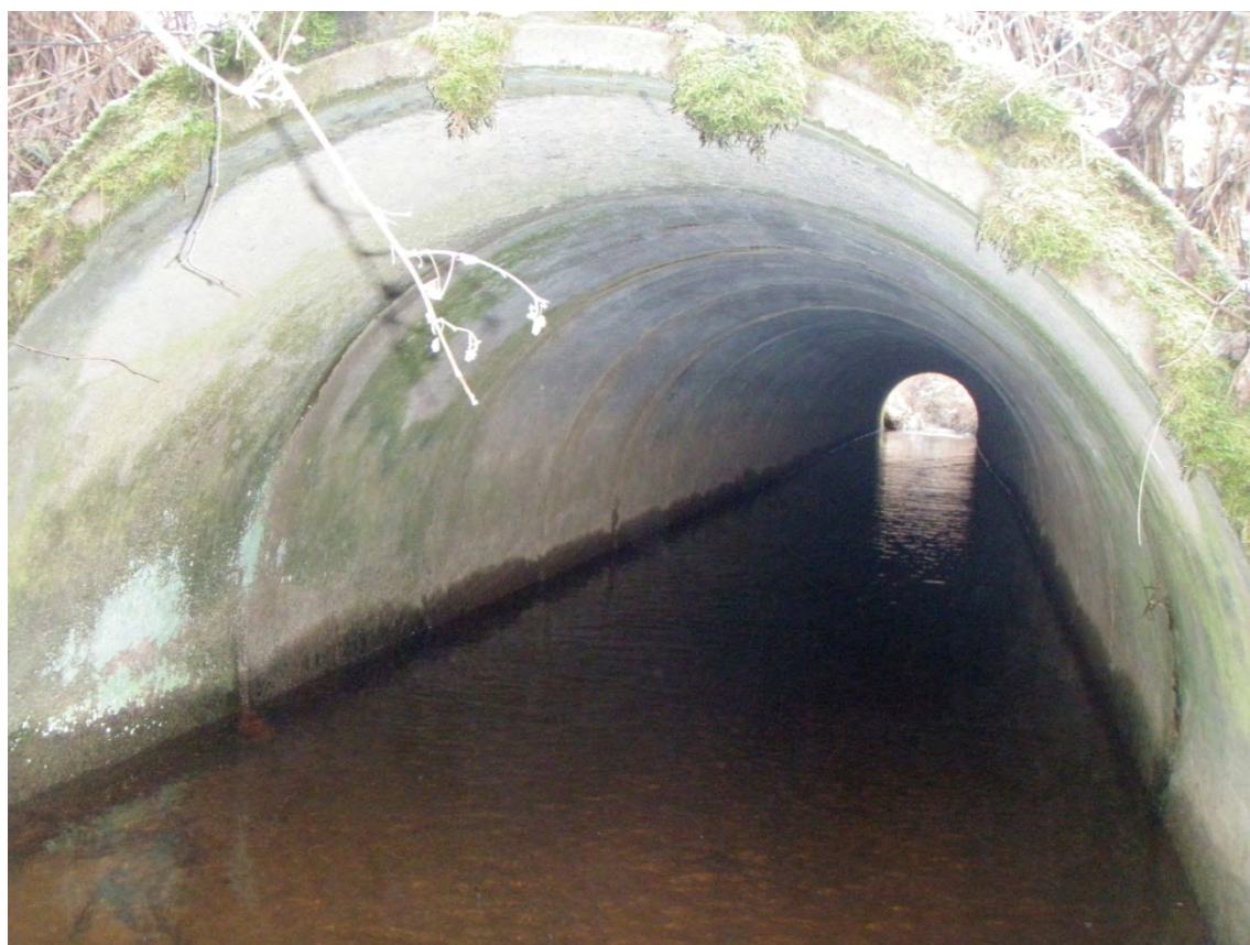
Bild 8. Delsträcka 5. Befintlig trumma under väg E20 ligger väl under nivåerna med uppströms och nedströms bäckbotten och utgör inget vandringshinder.
