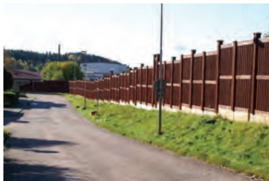
6.2:2 Befintligt bullerplank vid Kristineholm, krönhöjd cirka 4 m över väg.
