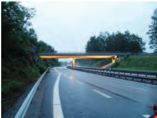
5.2:5 Bron i trafikplats Västra Bodarna
