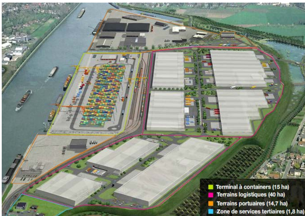
Figur 1 Liège Trilogiport. Källa: http://www.portdeliege.be/en/trilogiport
