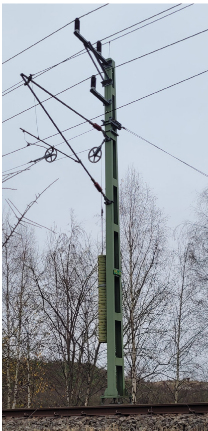
Figur 24. Kontaktledningsstolparna är idag grönmålade. Samma färg ska användas på eventuella nya stolpar.
