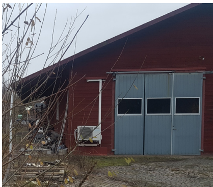
Figur 23. En faluröd färgsättning på teknikhus föreslås eftersom flera byggnader i närheten är just faluröda.
