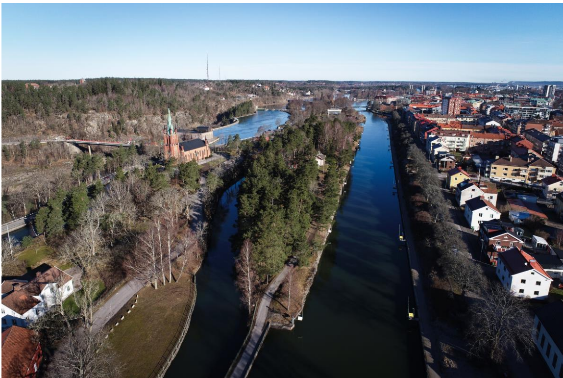
Bergkanalen i Trollhättan norr om Olidebron, nuläge
