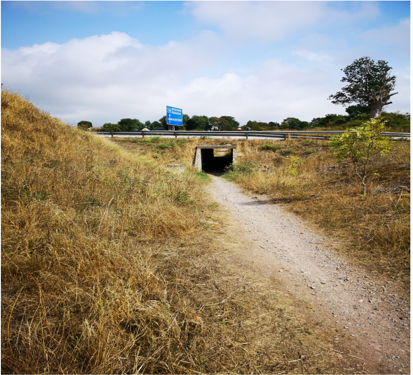
Nuvarande gångport vid Algutsrum
