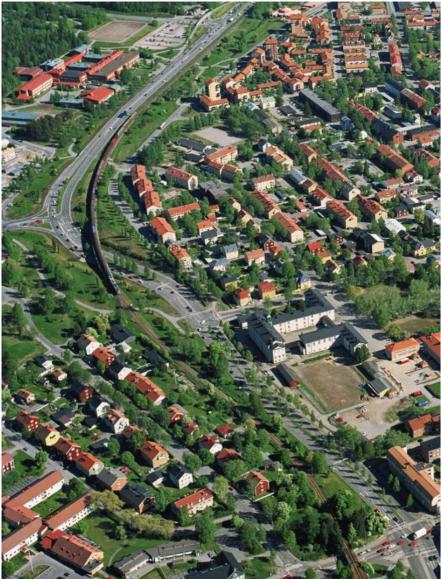
Flygbild över enkelspårsträckan mellan Umeå Ö och Umeå C, sett från norr. Ett godståg på väg norrut, på väg in mot Umeå C. Järnvägsbron över Östra Kyrkogatan längst ned i bild. Källa: INAB (bilden ursprungligen från Botniabanan AB)
