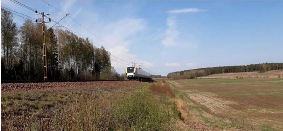
Vy norrut mot lämpligt läge för ett nytt mötesspår (vid borte skogsbrynet till höger)
