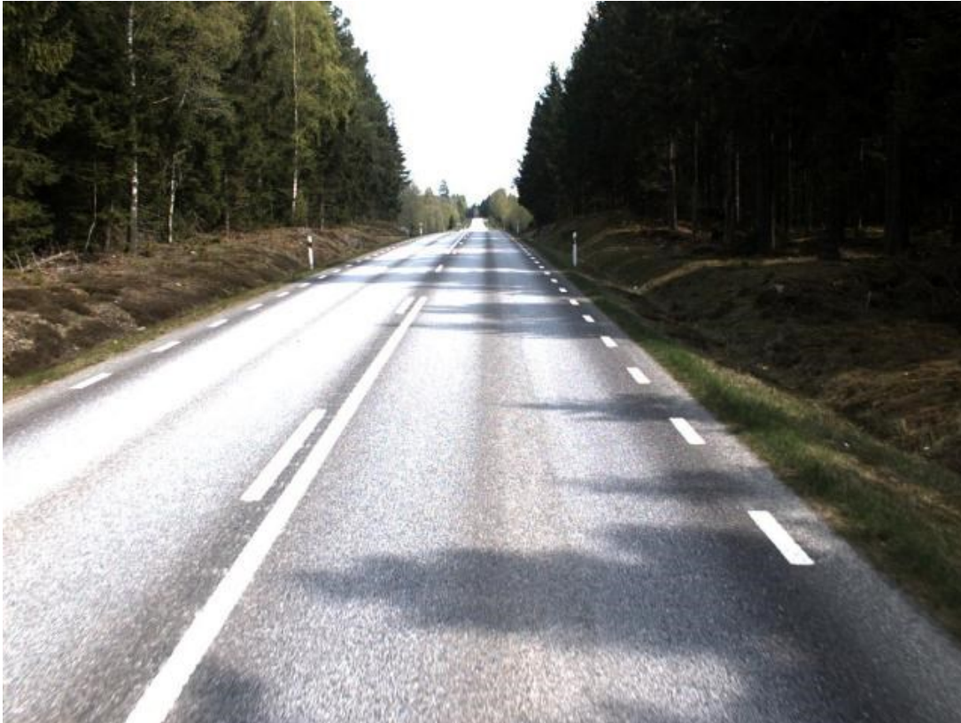
Figur 4 Befintlig väg 23 karakteriseras av långa raksträckor i plan med små konvexa och konkava radie i profil.
