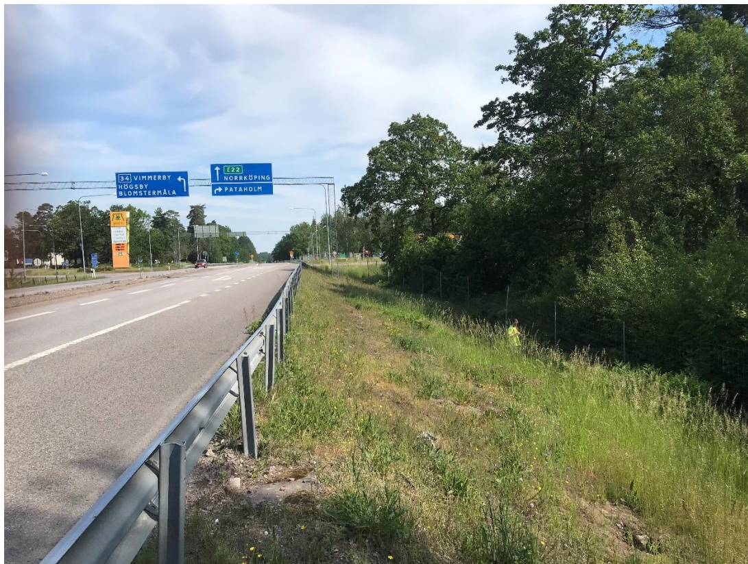
Väggkant öster om E22, söder om korsningen.
