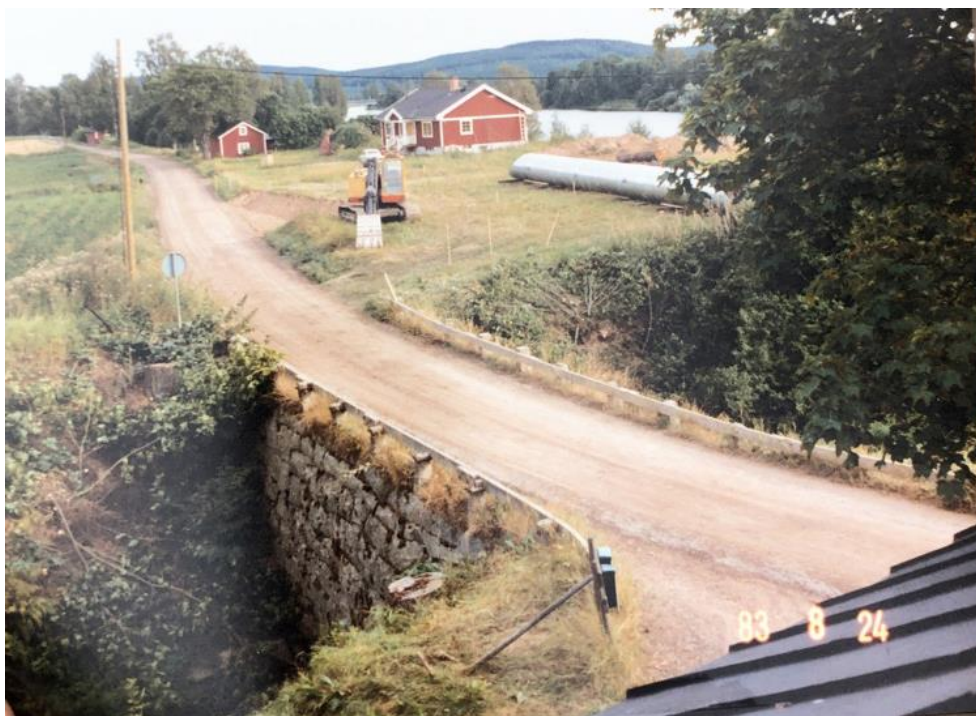
Figur 20. Vägmiljön vid Brogård, väster om Duvåker, år 1983 omedelbart innan borttagande av stenvalvsbro och breddning av väg 751.
