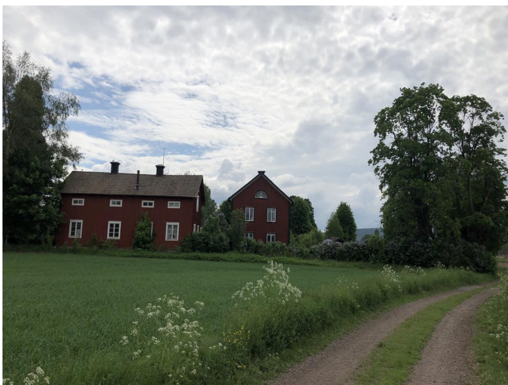
Figur 21. Vy mot söder och gården Nirs. Ny vägsträckning sammanfaller delvis med den befintliga grusvägen.
