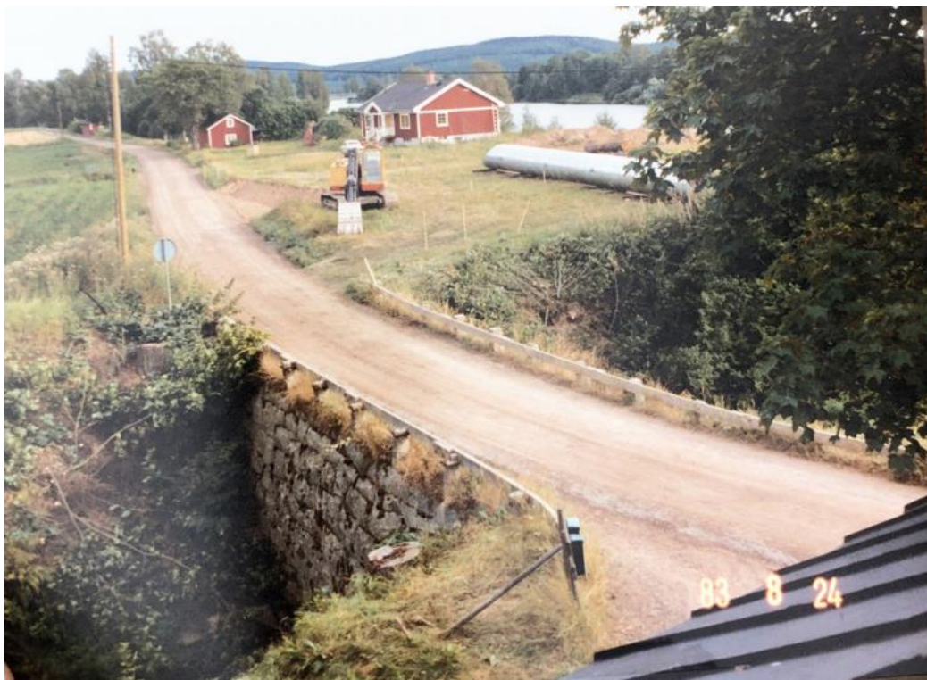
Figur 21. Vägmiljön vid Brogård, väster om Duvåker år 1983 omedelbart innan borttagande av stenvalvsbro och breddning av väg 751.
