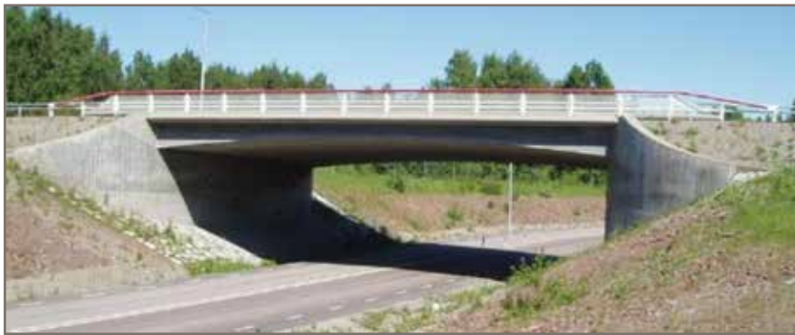
Figur 30. Exempel på balkrambro. Bild: Trafikverket
