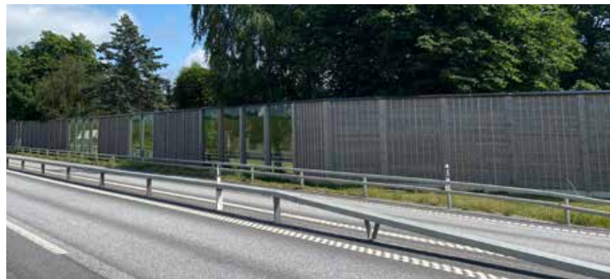
Figur 15. Bullerskärm. Här visas en naturgrå variant med stående lister i fyllningen och i kombination med genomsiktliga partier. Exempel från väg 19, norr om Ystad.
