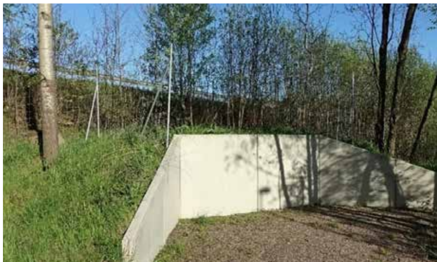
Figur 10. Exempel på viltuthopp i släntfot, uppbyggd av L-stöd i betong. Observera hur viltstängslet ansluter till uthoppet ovanpå stödkonstruktionen. Foto: Mats Lindqvist, TRV.
