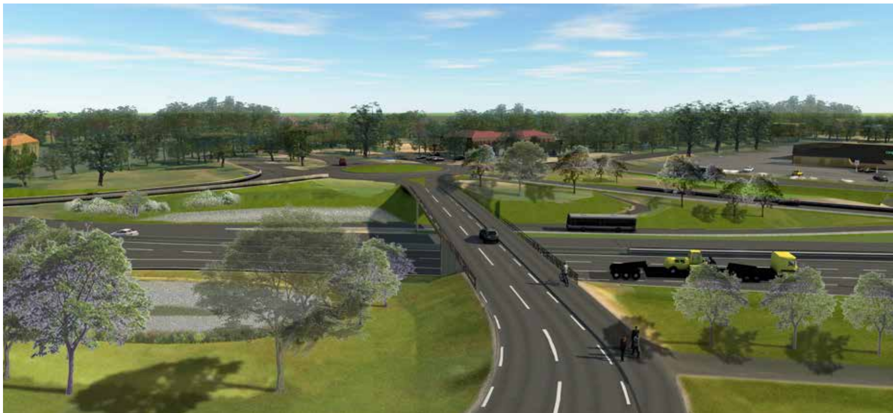
Figur 58. Illustration. Vy mot söder över Nättraby trafikplats sedd från Gamla landsvägen. Till höger bild syns GC-vägens nya placeringa över bron, en av busshållplatserna och den ombyggda avfarten från E22 mot den nya cirkulationsplatsen, mitt i bild. Till vänster syns de två dagvattenmagasinen, en på vardera sidan av E22. Bakom dessa skymtar Villa Ferh och den nya påfarten mot Karlskrona. Utbyggnaden på fastigheten Västra Nättraby 6:96 är inte med på illustration eftersom dessa har tillkommit efter att illustrationen skapades.
