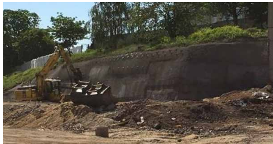
Figur 17. Jordspikning. Exempel från breddning av bangård i Södertälje. NRC Group. Bild: Trafikverket.
