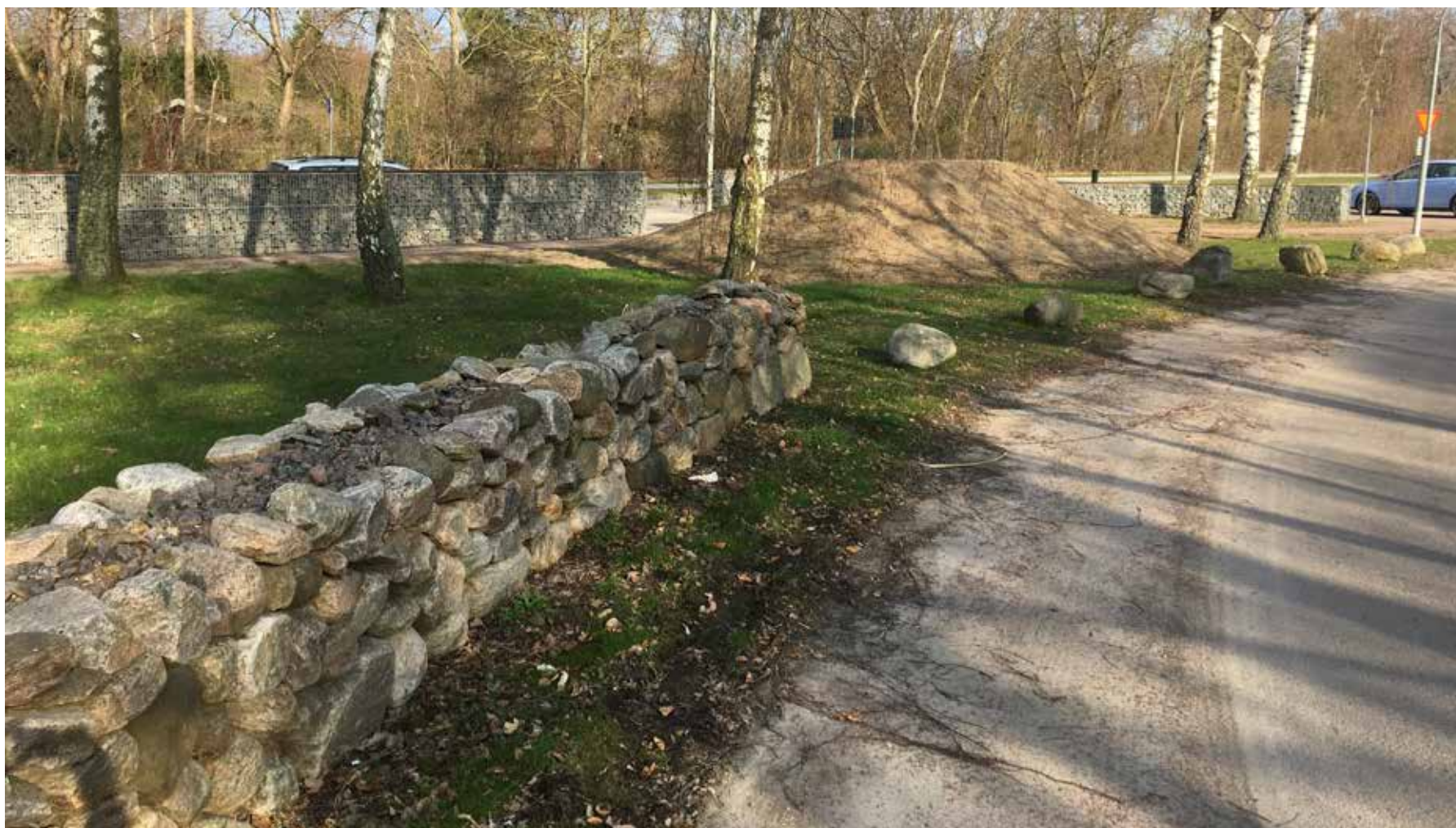
Figur 18. Bilden visar en kallmur av naturstenblock i förgrunden och i bakgrunden en gabionmur. Att kombinera båda murtyperna på samma ställe ser bra ut om de består av samma blandning av bergarter och har samma kulör. Annars bör de placeras med ett avstånd från varandra. Bilden är tagen i Helsingborg.
