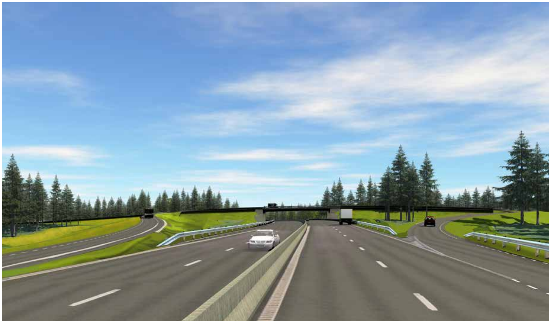
Figur 24. Björketorp trafikplats, vy från väster. Mellan motorvägen och avfarten till höger i bild syns sparade träd. Utanför påfarten till vänster i bild, anläggs sandiga slänter för sandödlor, dessa har illustrerats med gul färg.
