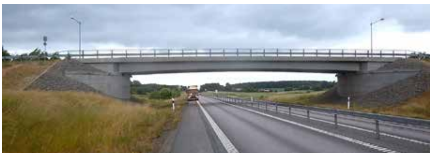
Figur 43. Exempel på brofäste, trafikplats Söderåkra, söder om Kalmar. Bild Trafikverket.
