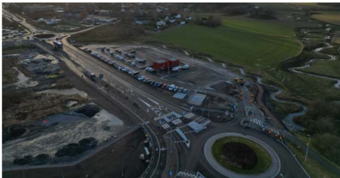
Pågående arbete med pendelparkering vid Skra bro. Foto: Ingemar Karlsson, Göteborgs Stad
