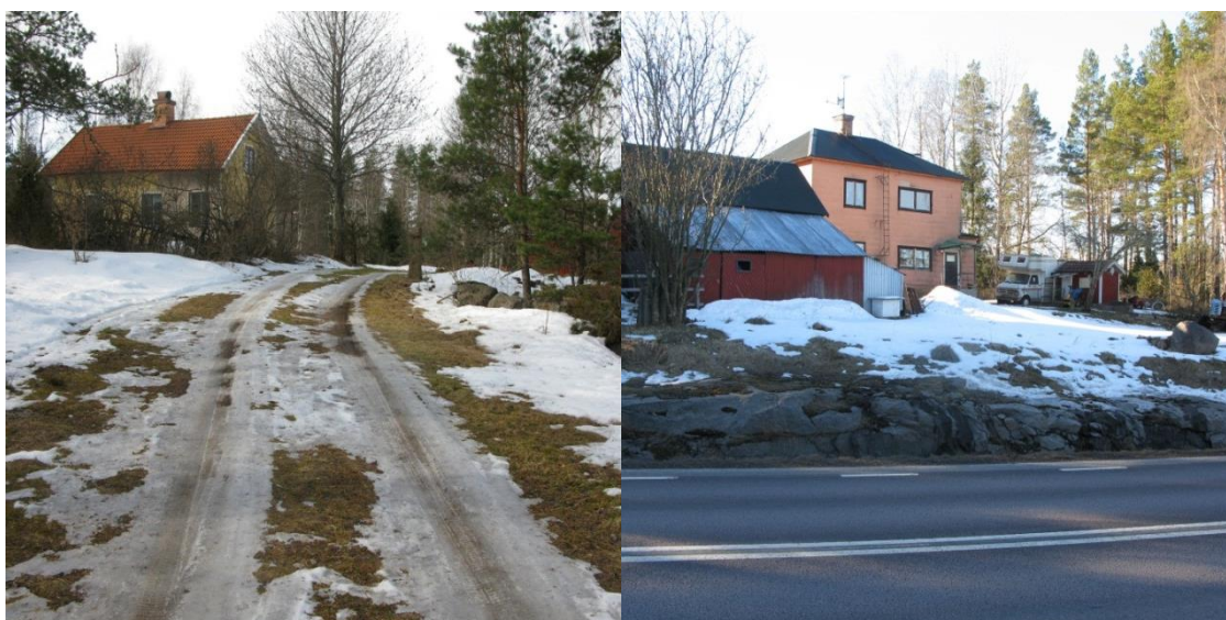
Figur 2.4.4.3. Bostadsbebyggelsen i Äspedal (Uppsala 1:7) och Ödhult som ligger i närheten av vägen. Bebyggelsen ligger i båda fallen ett par meter högre än vägen.
