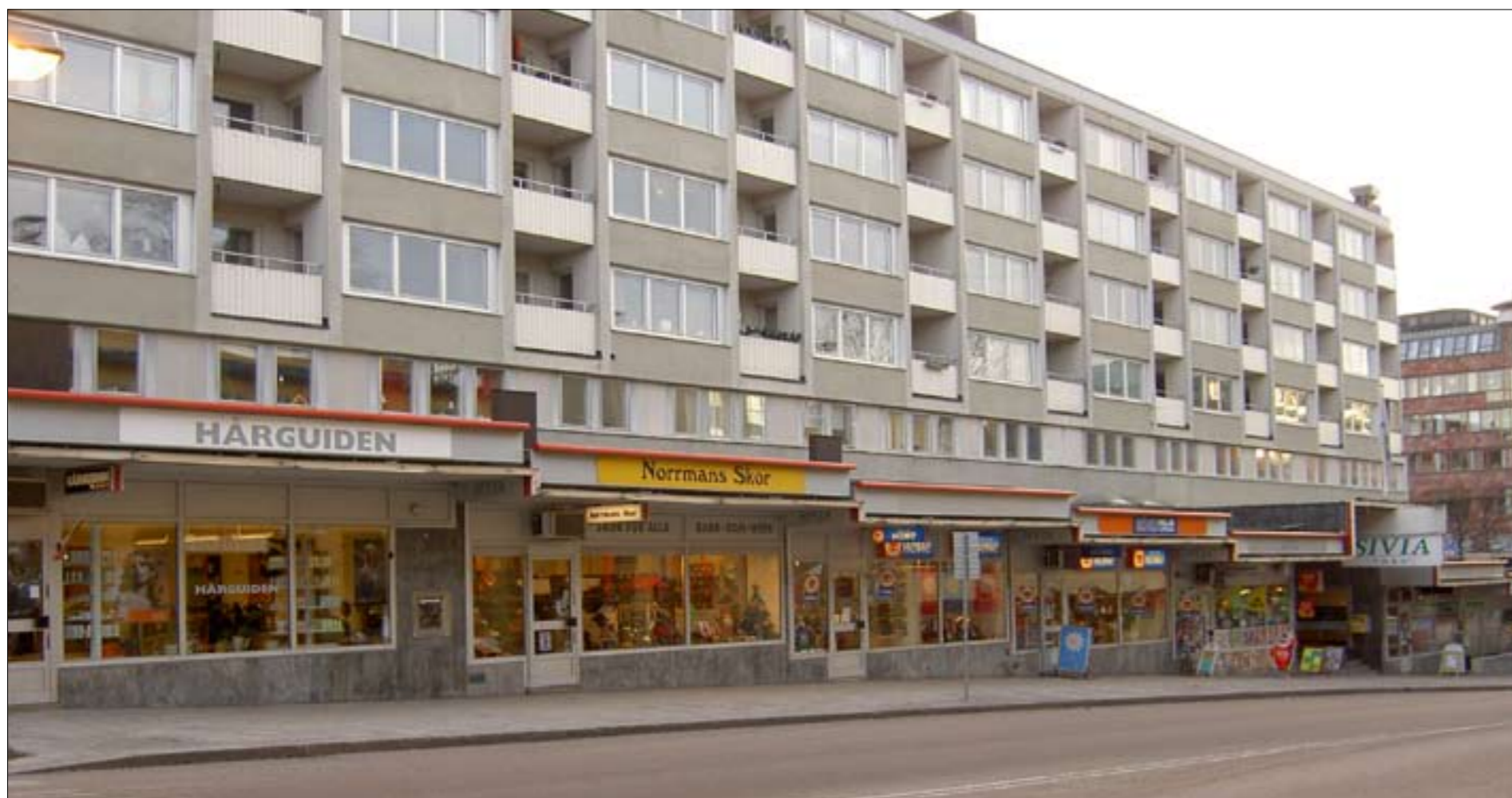
Bild 3. Verksamheterna längs med Vaksalagatan, på den östra sidan om järnvägen.
