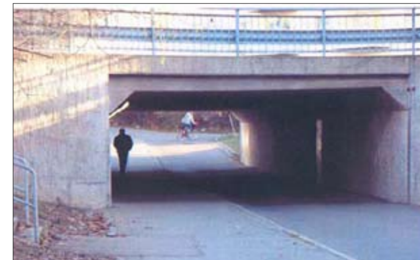
”Karaktär tunnel” - tunneln är mörk och inte genomblickbar vilket kan upplevas otryggt. Den här typen av utformning bör undvikas (Carl Magnus Berglund/VTI).
