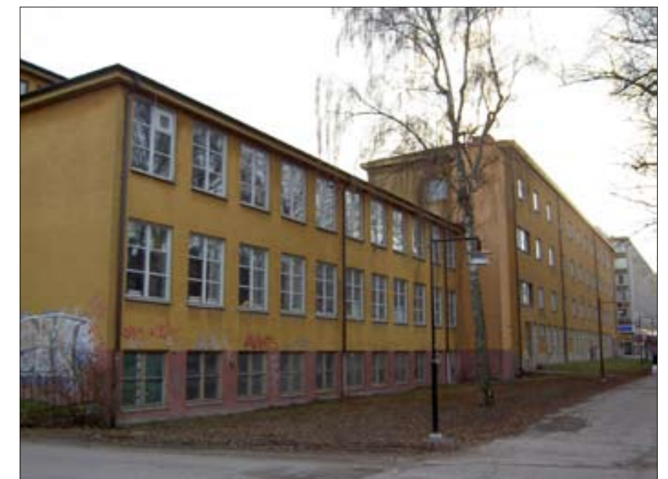
Bild 19. Nannaskolan från 1945 är en stram byggnad som idag inrymmer sportföreningar.
