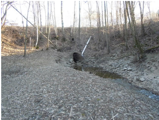
Figur 15. Området i Finngösaravinen där stödfyllning planeras.
