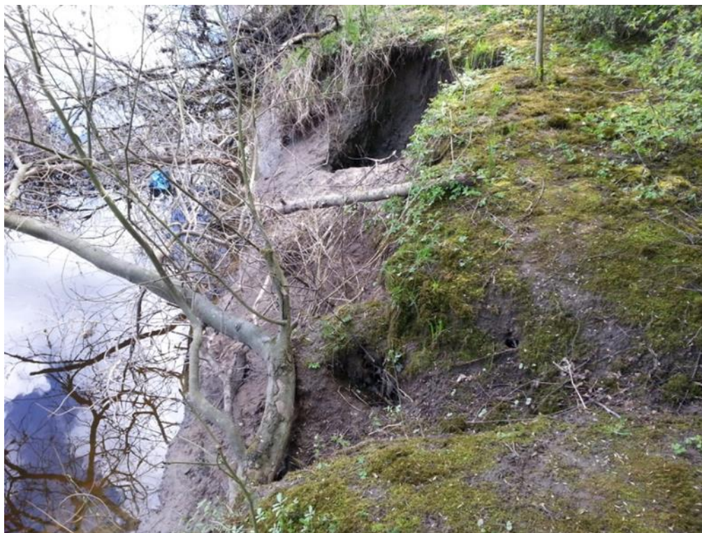
Figur 2. Erosion längs Säveån inom det planerade åtgärdsområdet.
