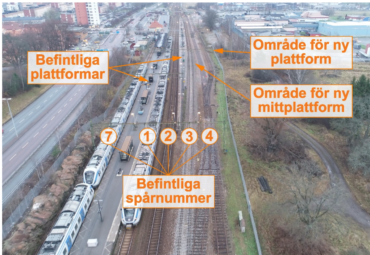
Figur 3. Befintlig anläggning vid Märsta station, söderifrån. Bilden är hämtad från Atkins drönarflygning.
