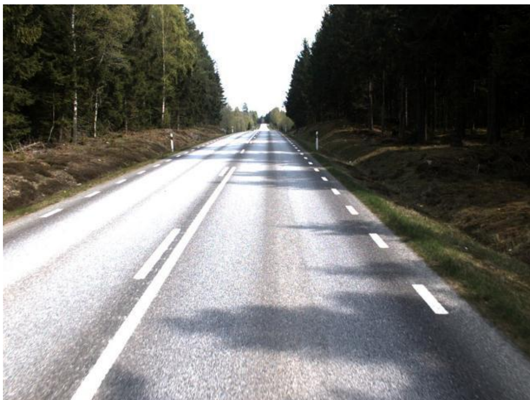
Figur 3 Befintlig väg 23 karakteriseras av långa raksträckor i plan med små konvexa och konkava radie i profil.
