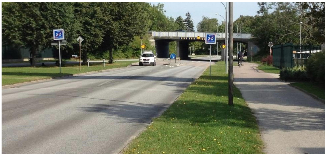
Figur 8 Tunavägen österut mot passagen under E22.
