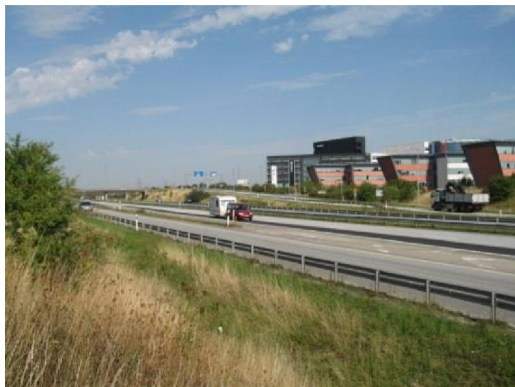
Figur 27 Fotografi över norra delen av vägplaneområdet i riktning mot trafikplats Lund Norra. E22 ligger i samma nivå som bebyggelsen omkring
