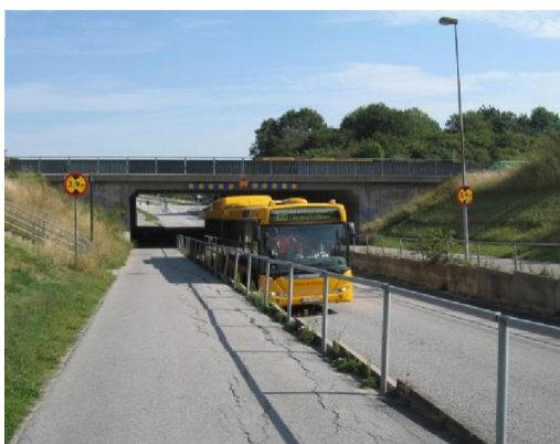
Figur 12 Passage under E22 där gång- och cykelvägar finns på båda sidor av Sölvegatan och separeras med nivåskillnad och räcke.
